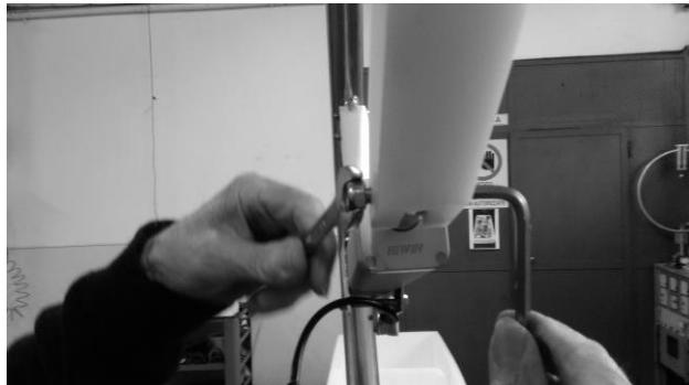
Jetzt verbinden Sie das Edelstahlblech mit beiden Loop-Hälften. Bestreichen Sie sämtliche Kontaktflächen sorgfältig mit der Leitpaste (beiliegend) bevor Sie die restlichen 3 Schrauben einsetzen.
