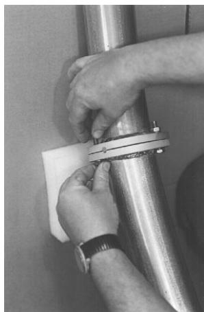
Si proceda infine all'unione delle due flange di precisione. NON DIMENTICARE di spalmare preventivamente la flangia che presenta il canale, con l'apposita pasta antiossidante, come descritto precedentemente.
